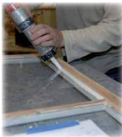
Energiglas monteras och kittas.
