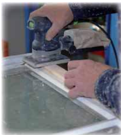
Eventuell träkomplettering, spackling och slipning.
